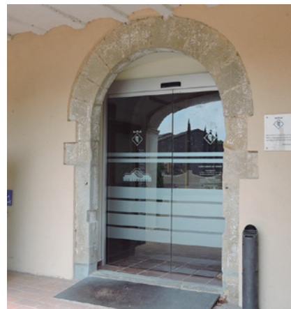
S'ha substituït la porta de fusta per una corredissa de vidre.
