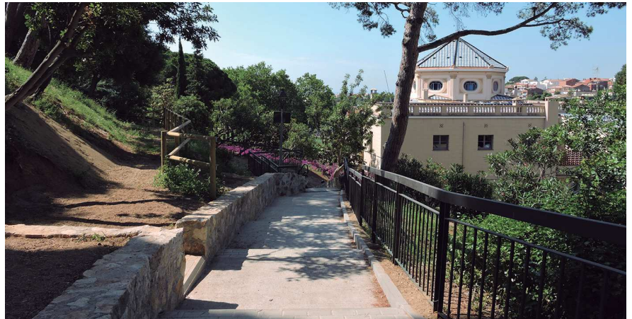
Les obres han permès de millorar les escales i el camí d'accés de vianants i també la imatge general d'aquest espai.
