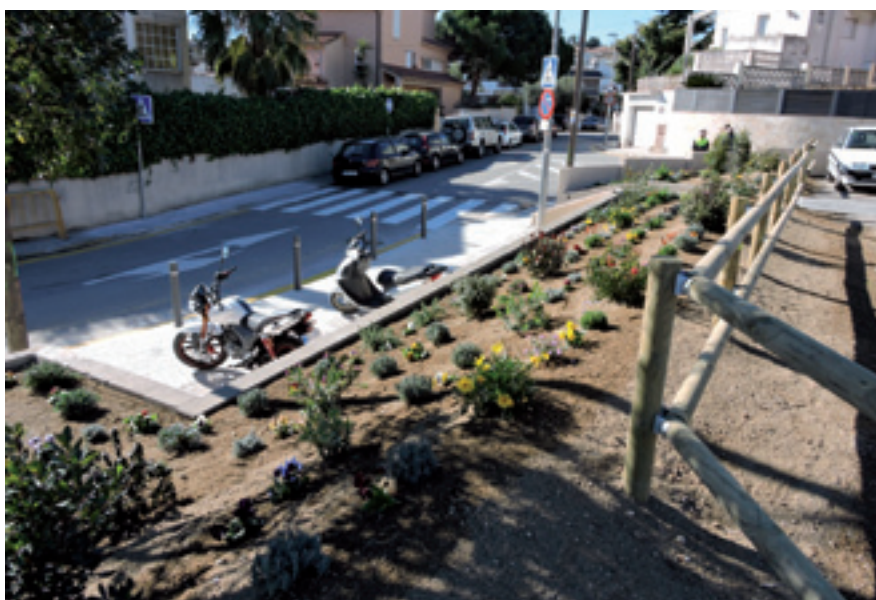
Les obres es van iniciar a començaments de desembre.
