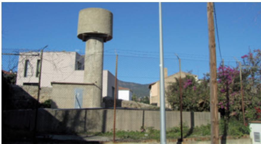
L'antic dipòsit serà enderrocat per construir la nova placeta i l'accés als habitatges.
