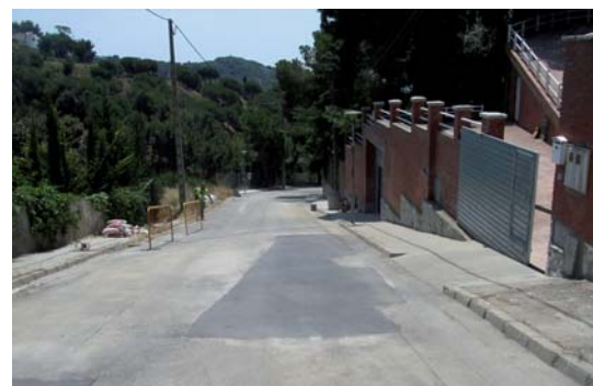
Reparació de la calçada al carrer Prat de la Riba.
