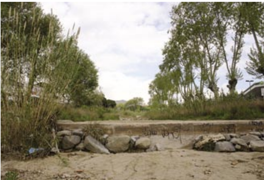
La intervenció pretén afavorir el bon funcionament hidràulic, bo i mantenint l'espai de la forma més naturalitzada possible.
