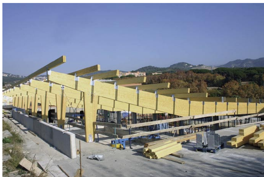
La piscina pren forma: des de finals de novembre ja té instal·lada la coberta de fusta.
