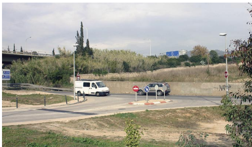
Les obres milloraran la seguretat d'aquesta intersecció i la fluïdesa del trànsit de la carretera.
