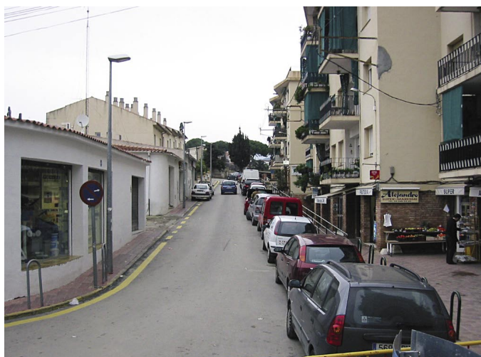
El solar destinat a l'aparcament es troba al capdamunt del carrer.
